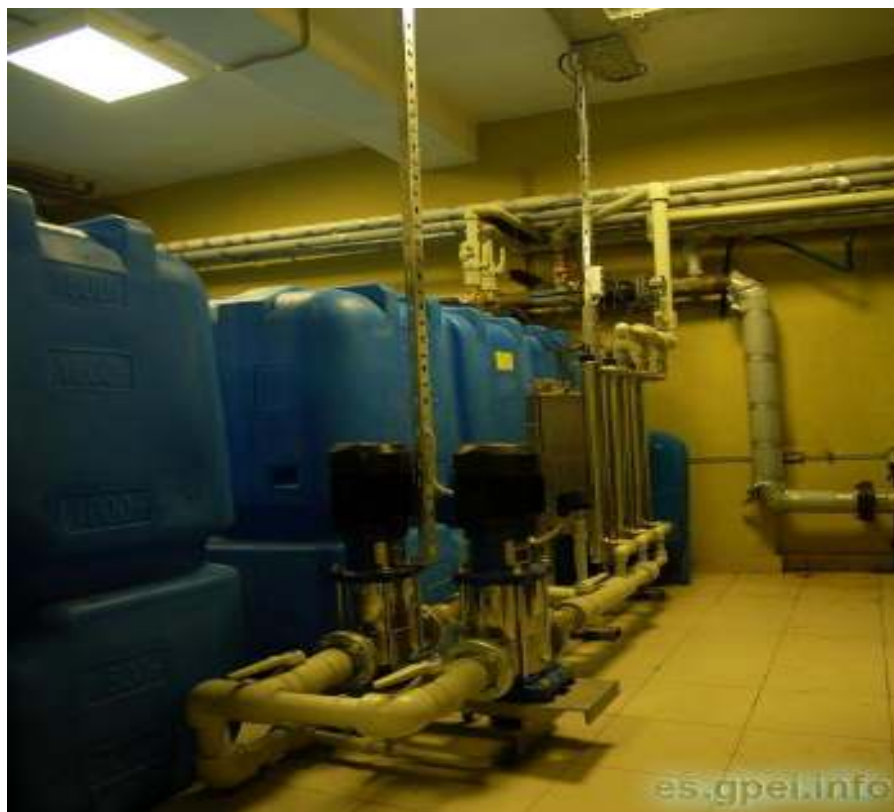
Рисунок 6. Внешний вид установки очистки воды серии ОРЕЛ (тип SWT)
